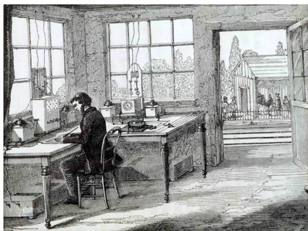
Gravure d'un poste de télégraphe électrique
